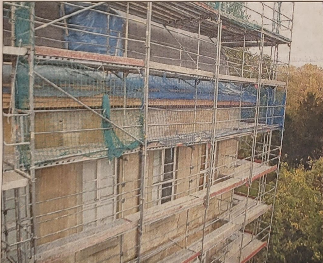
Die Arbeiten am Schloss gehen weiter: Die Fassade ist für anschließende Baumaßnahmen eingerüstet. ■ Fotos: Meyfarth
