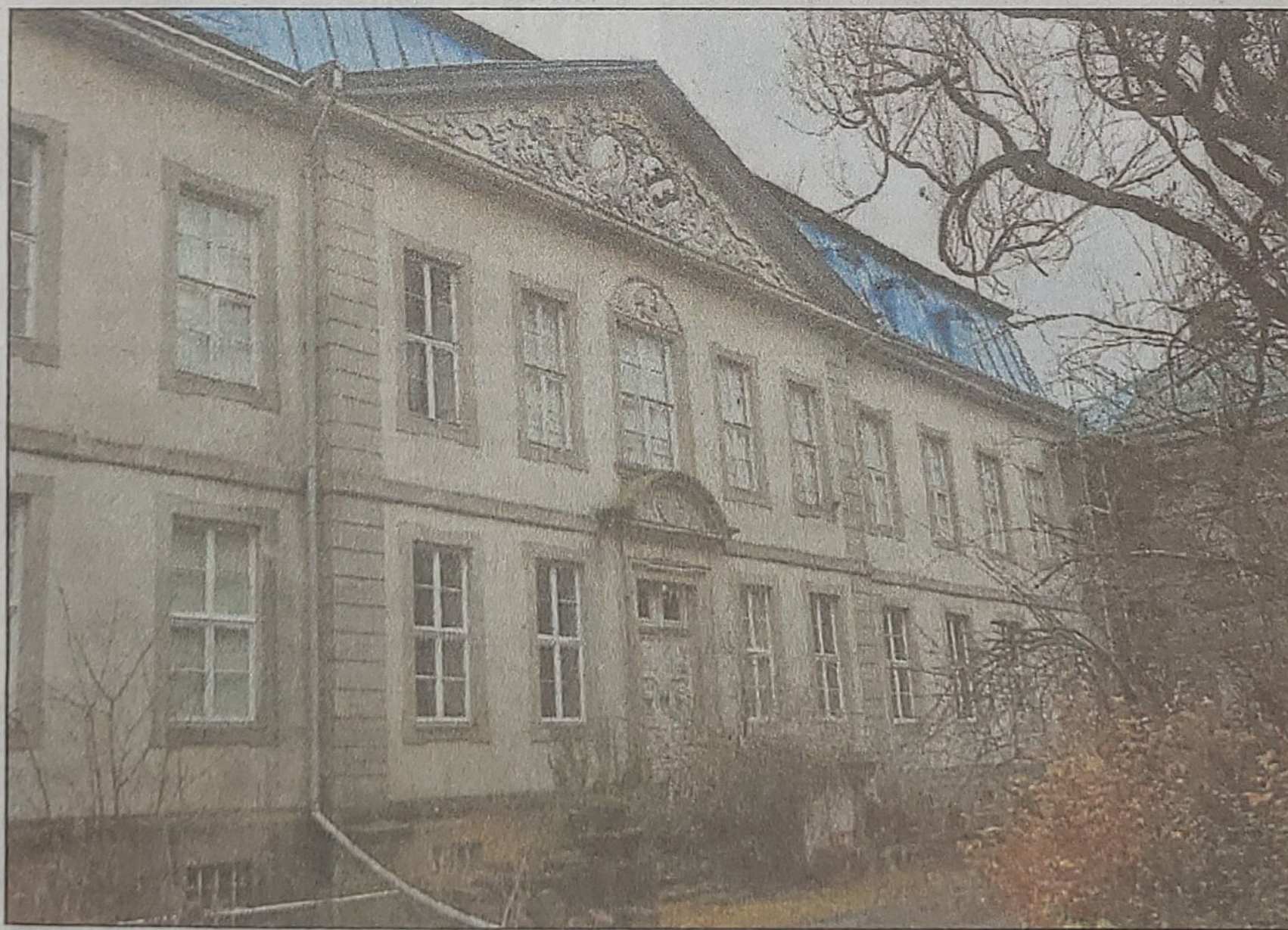
Für die Dachsanierung von Schloss Wrisbergholzen gibt es einen 25 000-Euro-Zuschuss.
