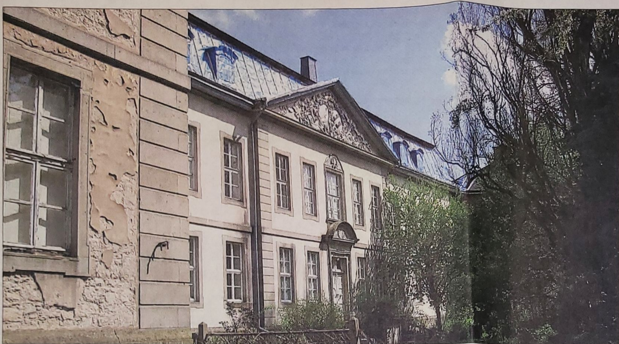
Ein Hoffnungszeichen für den Erhalt von Schloss Wrisbergholzen: Das Dach in Richtung Wirtschaftshof wurde mit Planen gesichert.
