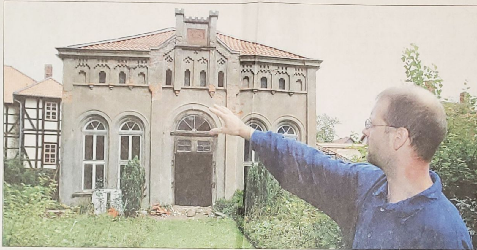
Noch fünf Jahre, dann wäre das Dach der Orangerie eingestürzt, sagt Jens Beck. Die Gefahr ist nun gebannt.
