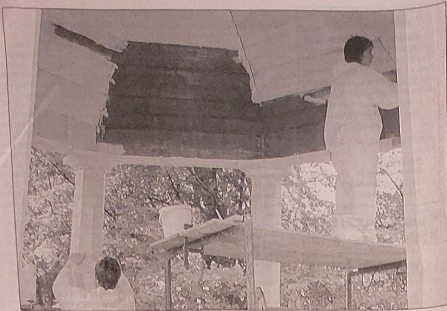
Erstrahlt bald im alten Glanz: Der „Teetempel“ erhält die erste Grundierungsschicht.
