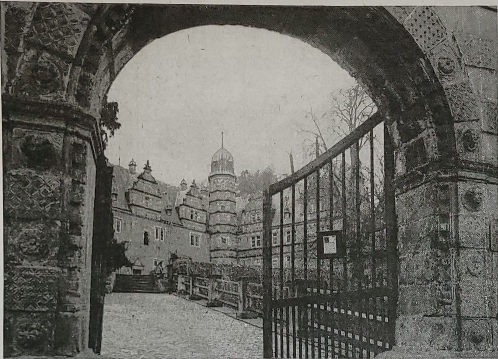
Hämelschenburg: Gegenwärtiger Bauzustand befriedigend, weil sich der private Besitzer, das Land und – eine löbliche Ausnahme – Kreis Hameln-Pyrmont die Kosten teilen. Der nächsten großen Reparatur wird jedoch mit Bangen entgegengesehen.
